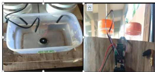
Gambar 9. Pemasangan Sensor TDS Meter
